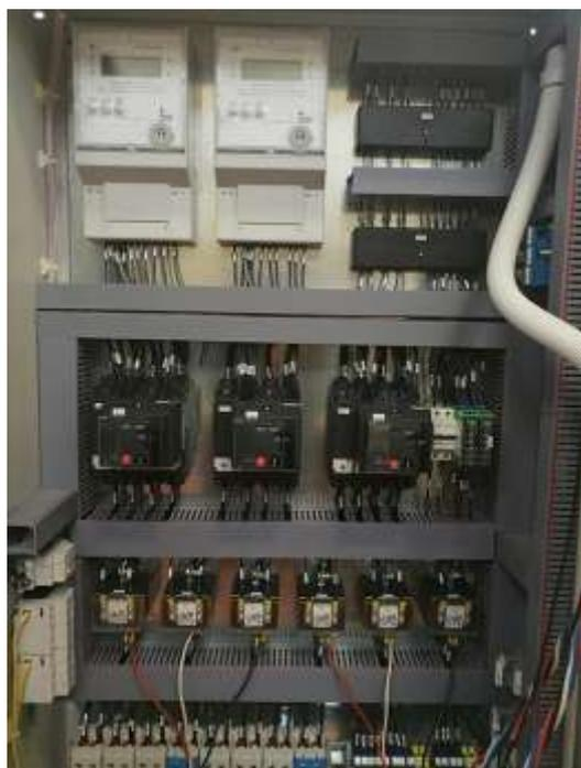
**Опция:** При необходимости шкаф оборудуется термостатом для регулирования температуры воздуха и вентиляторным блоком.
